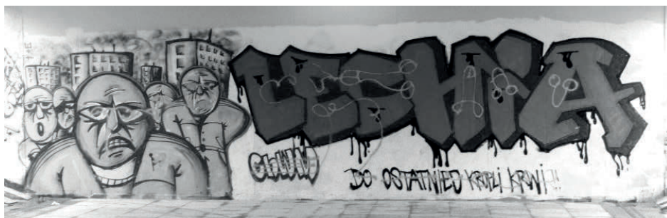
Abb. 5: Beschädigtes Wandbild der Lechia Gdansk-Hooligans an der Unterführung zur Haltestelle Startowa (Ostseite).
